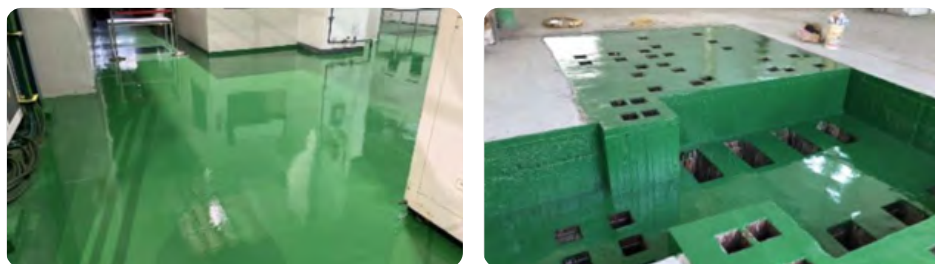
圖：回收矽製成環氧地坪塗料廠房新建工程
